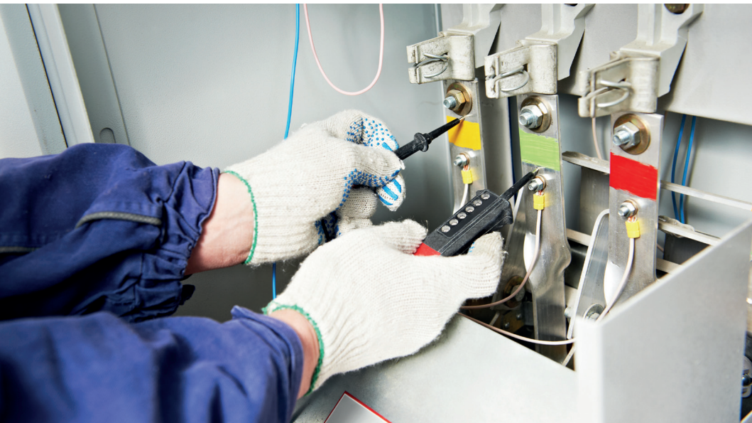
Abb. 2: Durch die Unachtsamkeit eines Kollegen stand der Anlagenteil der Baustelle, in dem Patrick arbeitete, unter Starkstrom.
